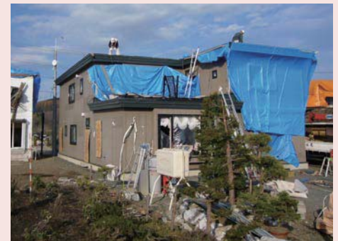
屋根の板金と野地、たるきが飛散 サッシのガラス破損（南面は割れたが、他は一部のみ） 外壁の損傷（飛来物の衝突による）
